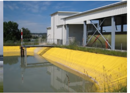
Bild 3: Stapelbecken und Gebäude für Destillation
