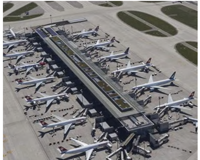
Dock E, Flughafen Zürich mit Photovoltaik-Anlage
