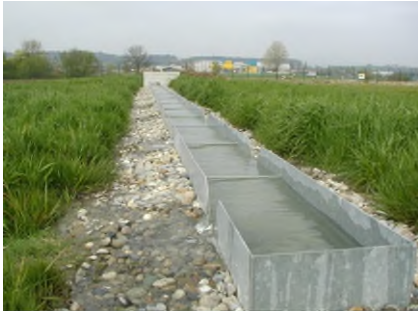
Bild 1: Retentionsfilterbecken
