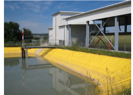
Bild 3: Stapelbecken und Gebäude für Destillation
