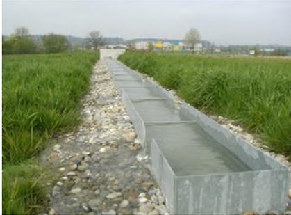
Bild 1: Retentionsfilterbecken
